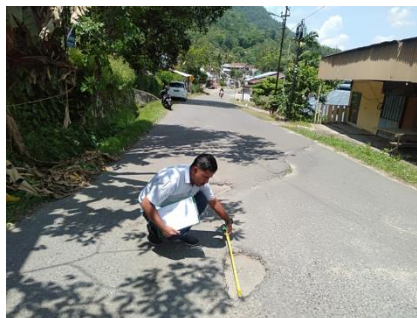
Gambar 4.2 Dokumentasi Retak Buaya ( Alligator Cracking )
